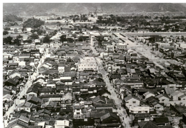
大手前通りの工事 (高橋秀吉コレクション)
