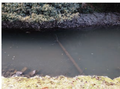
⑭ 配管（勢隠堀内）
