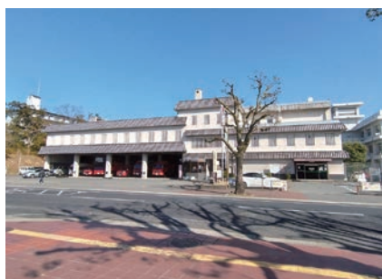
⑦姫路東消防署（姫路市中央支所）
