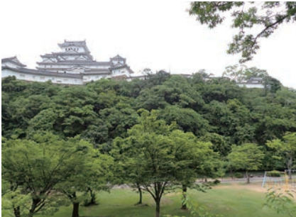
④全景（姫山公園より）
