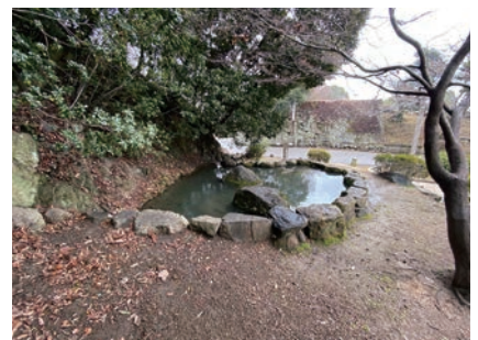
⑫堀水循環用ポンプ施設
