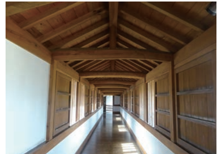
②④西の丸仮設廊下
