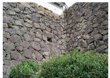
⑮水曲輪排水溝
