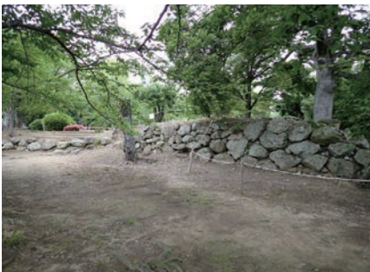
⑦御本城土蔵基礎石垣
