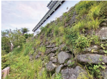
⑤石垣（樹林側）
