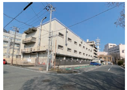
⑮N T T施設 (1号館)
