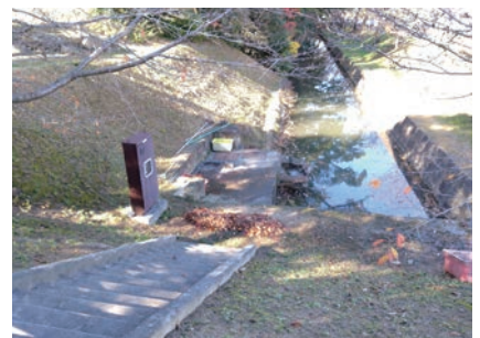
⑮北部ポンプ施設
