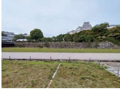
⑤折廻除米蔵跡石垣
