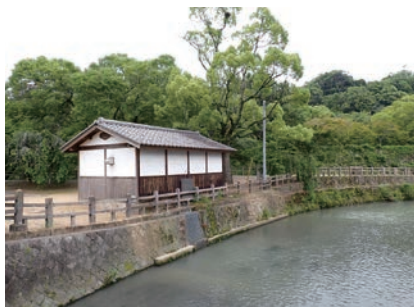
⑭西部中堀ポンプ施設
