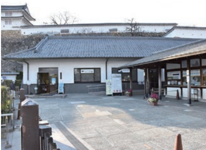
②②姫路城防災センター
