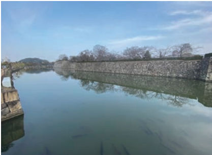
④ 南部内堀（桜門橋以西）
