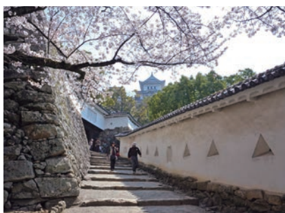
⑭石垣・石階・土堀
