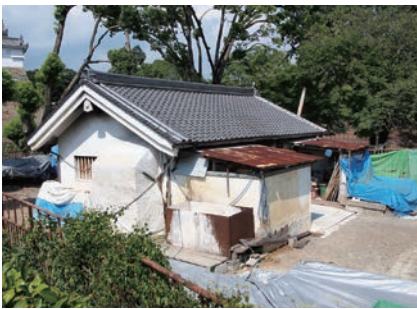
⑦作業場（左官小屋）
