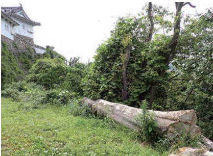
⑩樹林と建造物
