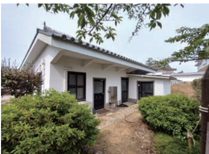
②⑤ポンプ室
