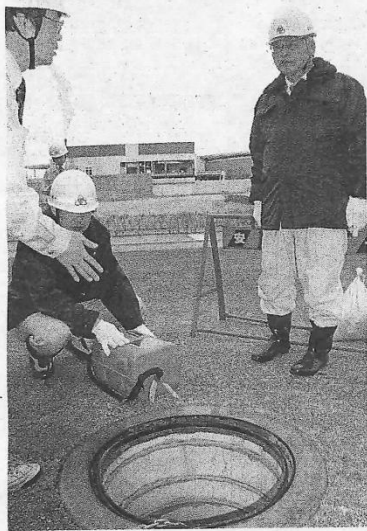
高濃度の可燃性ガスが検出されたマンホールを視察する平野東大名誉教授（右端）＝姫路市のエコパークあぼし
