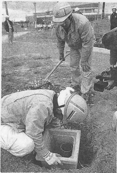
可燃性ガスを空気中に放出するため、敷地内に埋設された集水管に穴を開ける作業員ら ＝姫路市のエコパークあぼし
