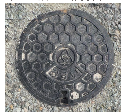
公共ますは直径約30cmの円形のものですが、設置工事に際しては約1m四方の土地を必要とします。
