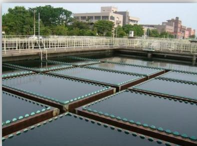
中部析水苑は姫路市最大の下水道終末処理場であり、昭和54年4月に供用開始しました。姫路市の人口の57.5%にあたる汚水を処理しており、平成25年度末の処理能力は220,000m<sup>3</sup>/日となっています。
