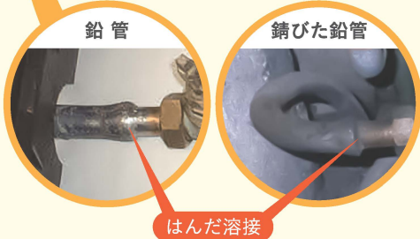
鉛製給水管の接合部(例)
