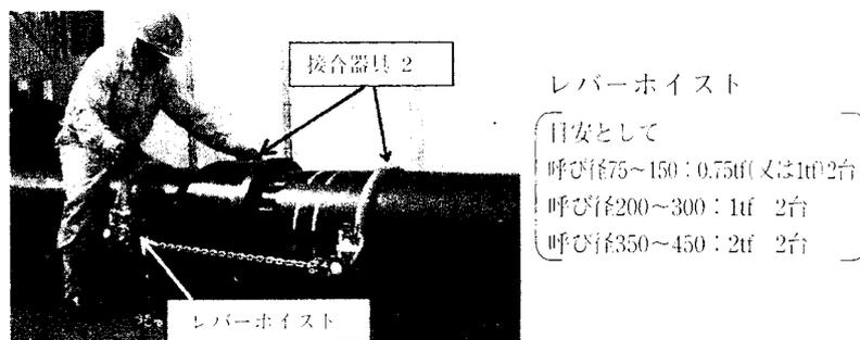
図11-19-2 レバーホイストを用いた接合器具2（呼び径75～450）
