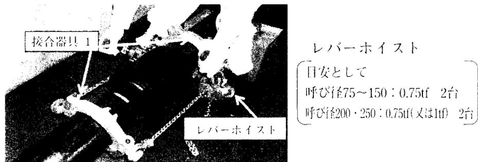
図11-19-1 レバーホイストを用いた接合器具1（呼び径75～250）
