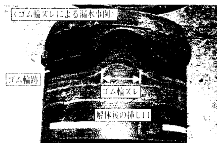
図 11-22 ゴム輪ズレによる漏水事例
