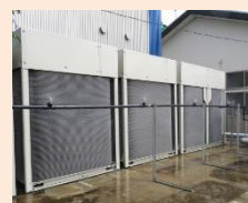
室外機への散水
