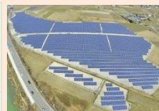
大規模な太陽光発電所
