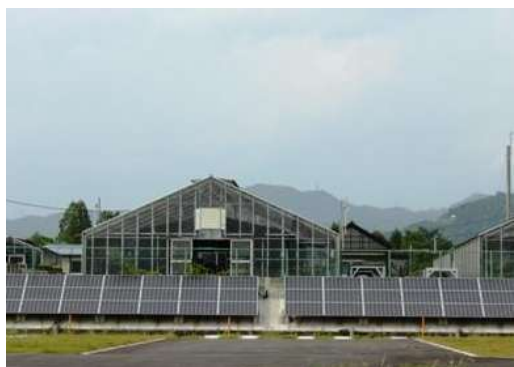
太陽光発電パネル（農業振興センター）
