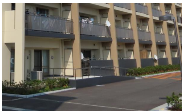
市営住宅の1階バリアフリー住戸
