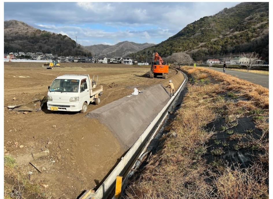
鉄鋼スラグによる畦畔の舗装と通電性向上
