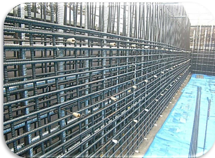
配水池の壁鉄筋の組み立て状況 (銀色に見えるのがPC鋼棒等のシース管)
