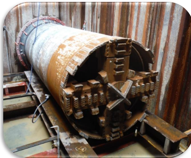
通過立坑に到達した 掘進機の状況
