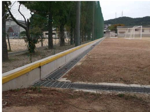
校庭等を雨水が貯留できる構造にすることにより、雨水の流出を抑制する。
