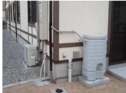
屋根等に降った雨水を溜めることにより、雨水の流出を抑制する。
