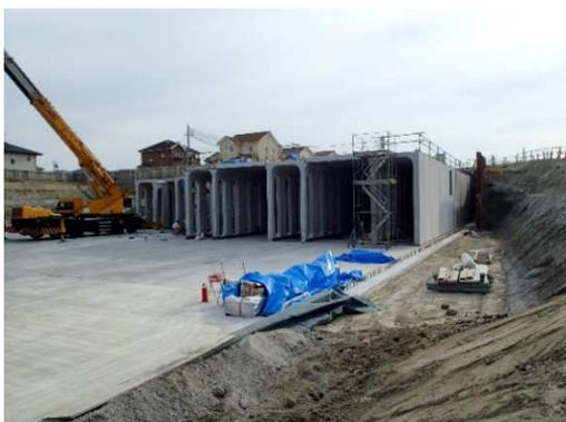
雨水流出量が放流先河川の許容量を超える場合、雨水流出を抑制するため、一時的に雨水を溜める。
