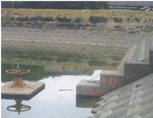
既存ため池の空き容量を活用し、雨水を貯留することで、雨水の流出を抑制する。
