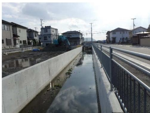
排水路等の幅を広げたり、底を深くする等の改修により、排水能力を増強させる。
