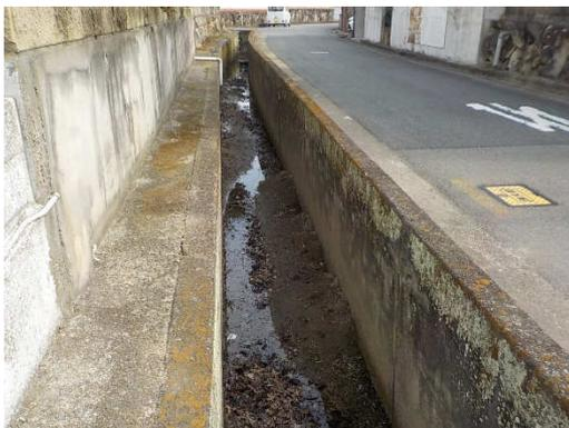
河川、水路等の浚渫により、雨水排水施設の機能を十分に発揮できるようにしておく。
