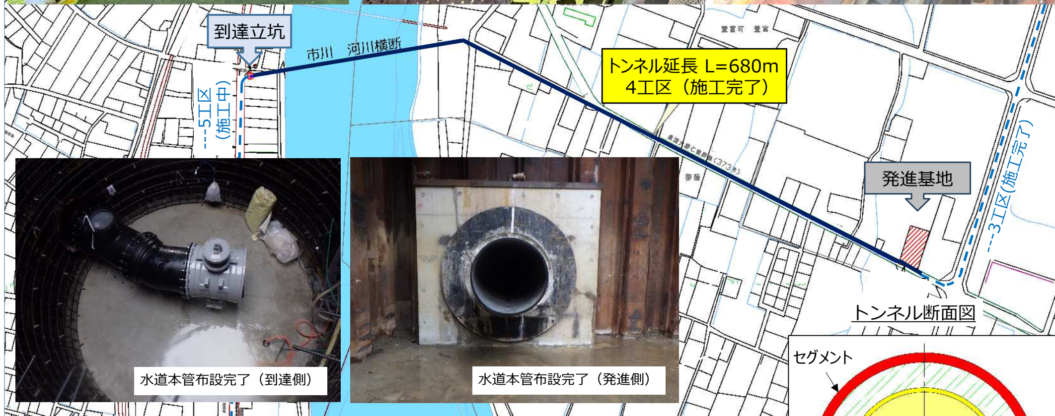
二次覆工（水道本管の材料）
