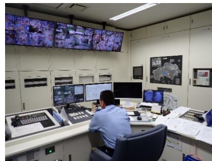
姫路城防災センター
