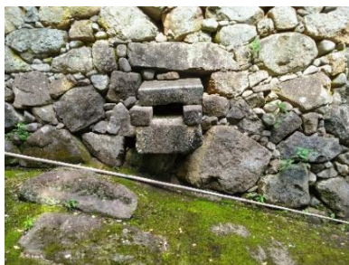
曲輪内からの排水溝
