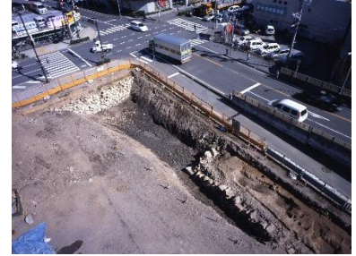
北条口門土橋石垣
