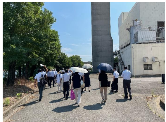
敷地東側、河川（海）との境
