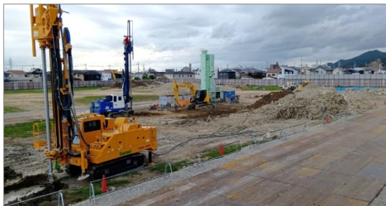
9月14日 地盤改良（柱状改良）工事の様子
