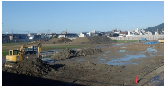
9月30日 基礎掘削工事中的様子
