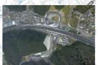
⑨夢前スマートインターチェンジ
