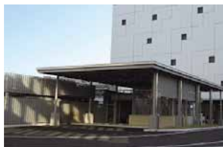
▲姫路駅北駅前広場東側一般車乗降場 (帰宅困難者等の支援対策施設)
