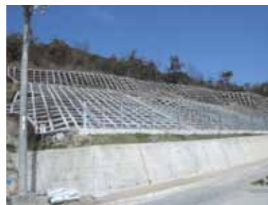
▲治山工事後の現場
