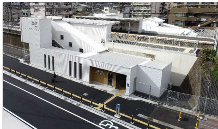
山陽電鉄網干線 夢前川駅（駅舎バリアフリー化）
