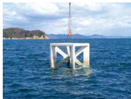
コンクリート製の魚礁
