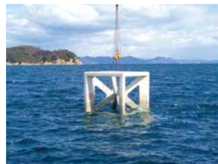
コンクリート製の魚礁
