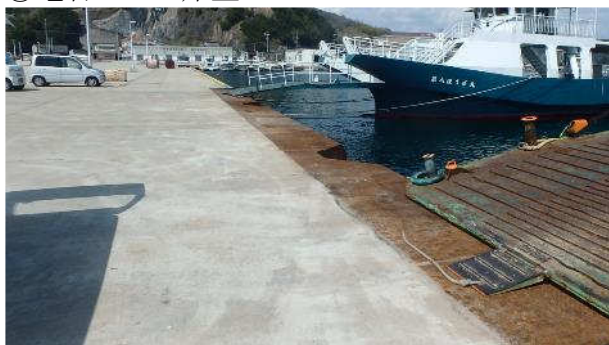
⑮亀岩-3.5m岸壁
