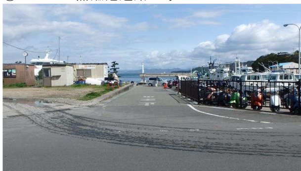
⑰カマスガ浦臨港道路3号
