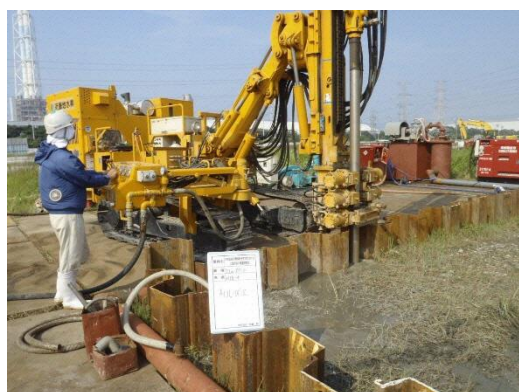
写真 3-2 ウェルポイント設置状況
