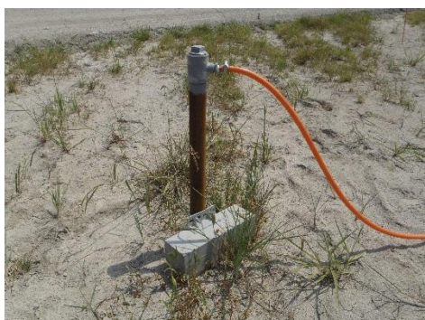
写真 5-3 空気注入管
