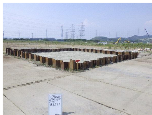
写真 3-7 埋め戻し完了
