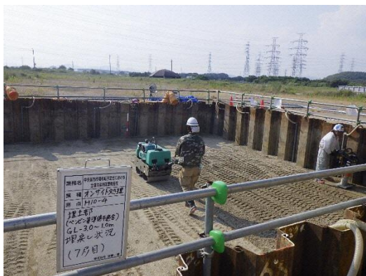
写真 3-6 埋め戻し、転圧状況
