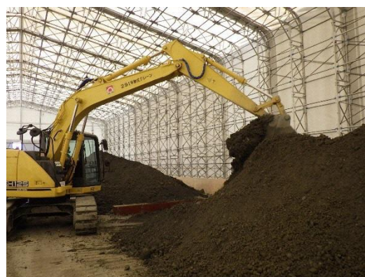
写真 3-5 土壌混合・攪拌状況 (バックホウ)
