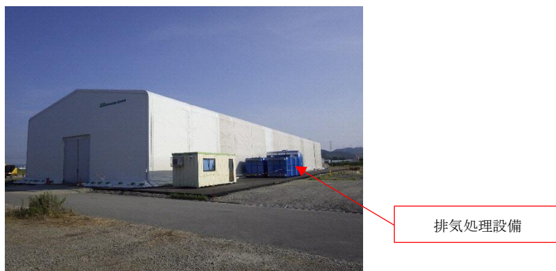
写真 3-1 仮設テント設置状況
