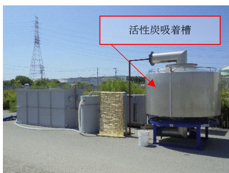
写真 5-1 エアースパージングユニット
