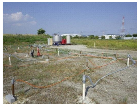
写真 5-2 エアースパージング配管
