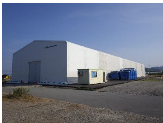
写真 3-1 仮設テント設置状況
