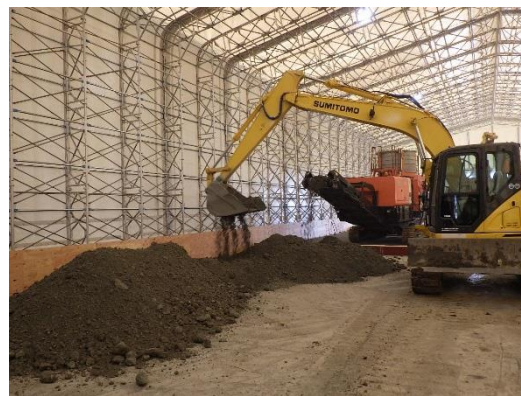
写真 3-2 仮設テント内作業状況
