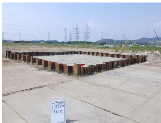
写真 3-10 埋め戻し完了
