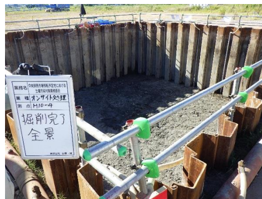
写真 3-6 ベンゼン基準超過土壌掘削完了 (H10-4 区画)
