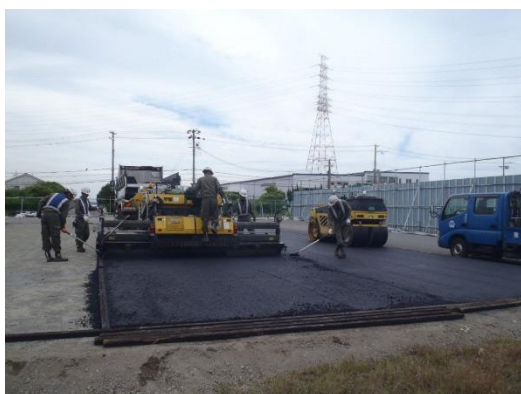
写真 2-3 アスファルト舗装設置作業状況
