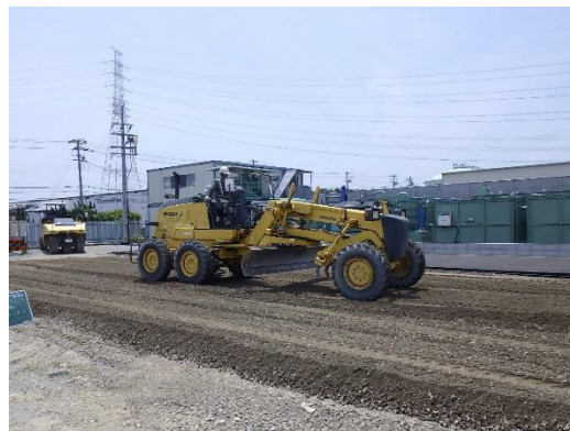
写真 2-2 仮設道路設置作業状況②
