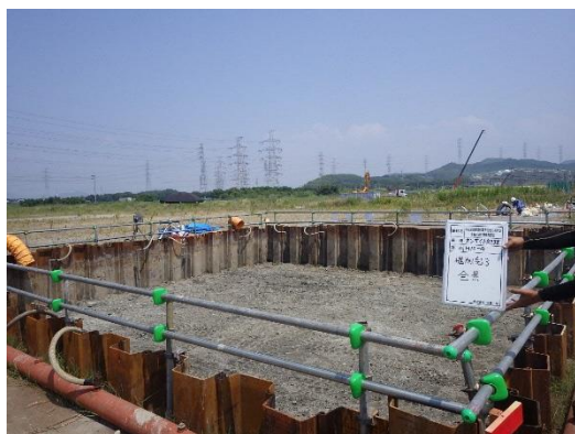
写真 3-5 ベンゼン基準適合土壌掘削完了 (H10-4 区画)
