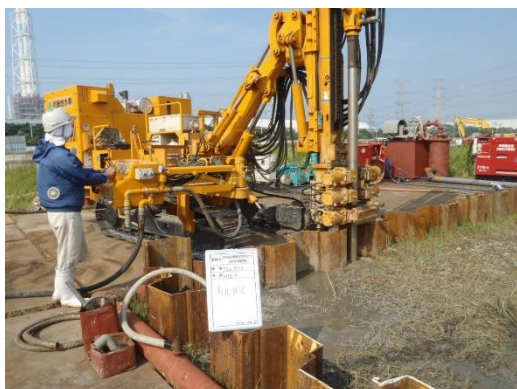
写真 3-3 ウェルポイント設置状況 (H10-4 区画)
