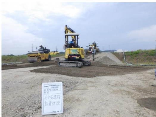
写真 2-1 仮設道路設置作業状況①
