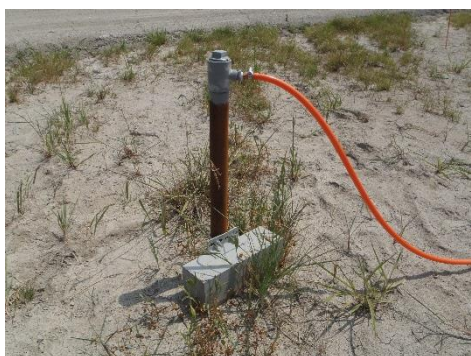
写真 5-3 空気注入管
