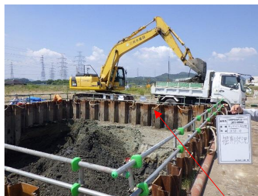
写真 3-4 掘削状況 (H10-4 区画)
