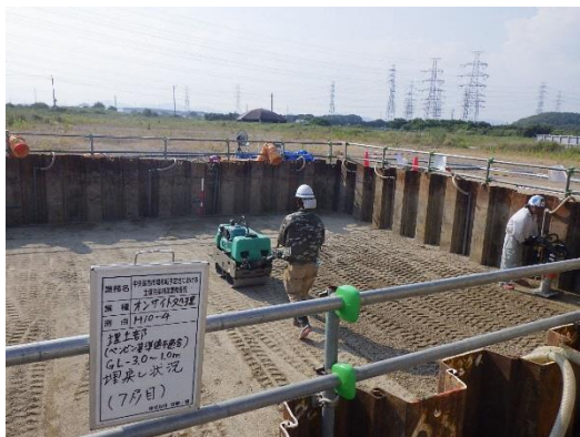
写真 3-9 埋め戻し、転圧状況
