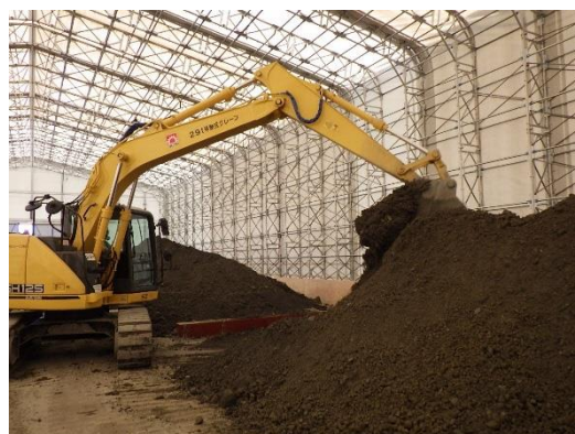
写真 3-8 土壤混合・攪拌状況 (バックホウ)
