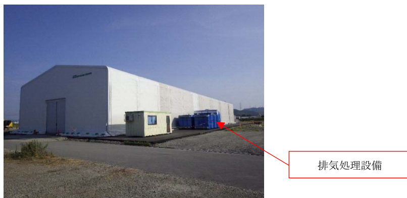
写真 2-1 仮設テント設置状況
