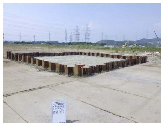
写真 2-13 埋め戻し完了
