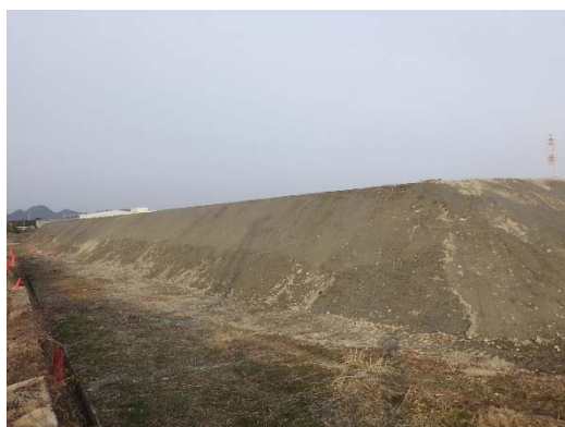
写真 7-2 盛土仮置場(1) (敷地南西側)
