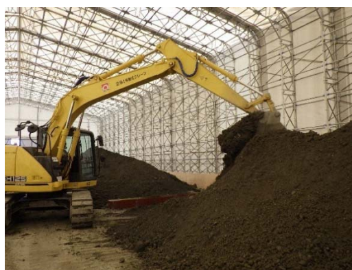
写真 2-9 土壤混合・攪拌状況 (バックホウ)
