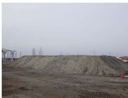
写真 7-3 盛土仮置場(2)-1 (敷地南東側)
