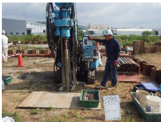
写真 3-3 確認ボーリング状況
