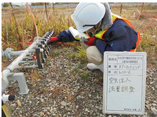
写真 4-5 空気注入流量調整状況
