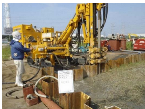
写真 2-4 ウェルポイント設置状況
