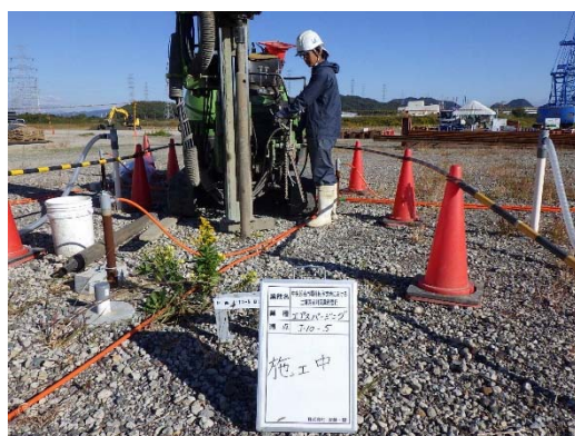
写真 4-7 確認ボーリング状況
