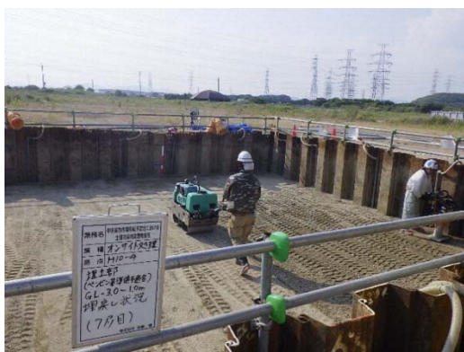
写真 2-12 埋め戻し、転圧状況
