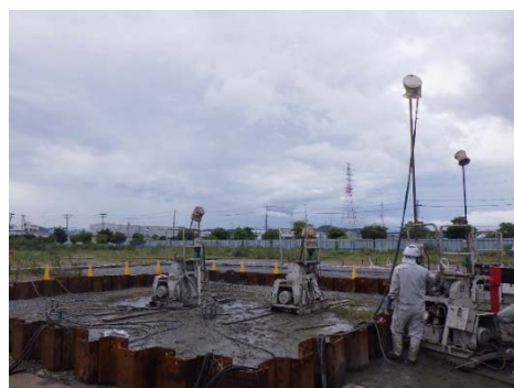
写真 2-6 薬液注入状況
