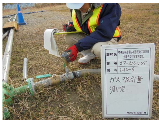
写真 4-6 ガス吸引量測定状況
