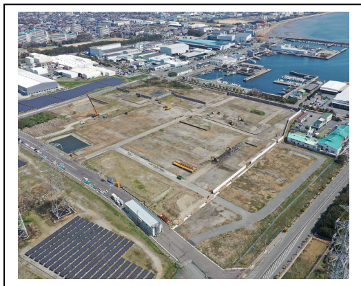
写真 2. 2. 1-1b 着手前全景
