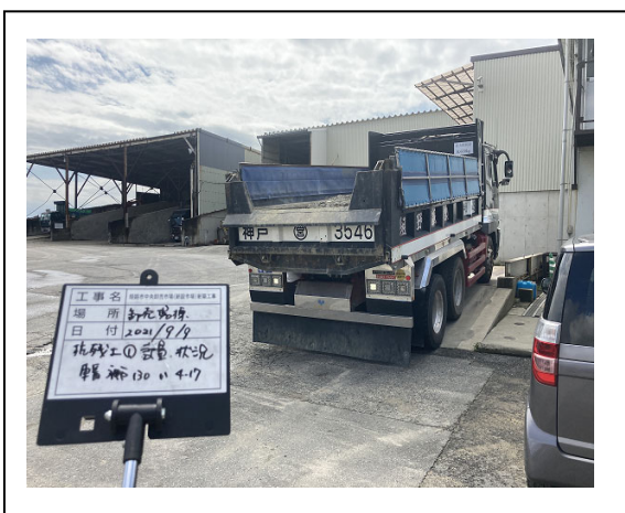
写真 2. 2. 5c 杭残土の仮置き・処理状況
