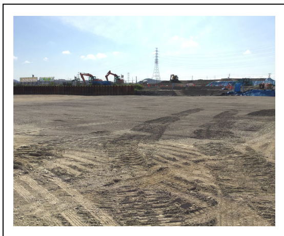
写真 2. 2. 2b 杭打設前基面整生状況
