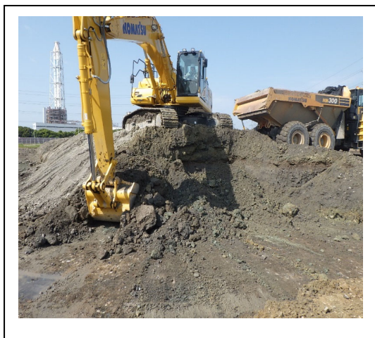
写真 2. 2. 1-3b 盛土鋤取り・積込状況
