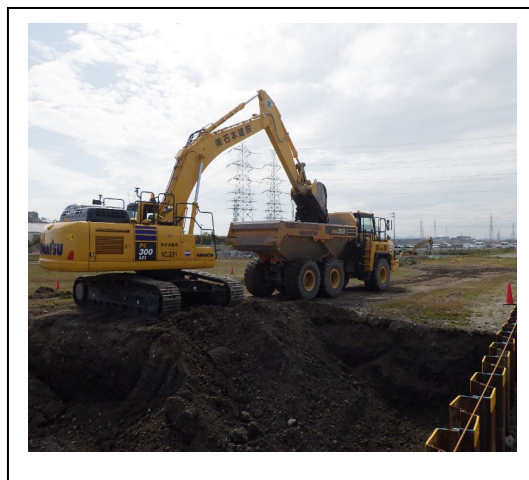
写真 2. 2. 1-3b 盛土鋤取り・積込状況
