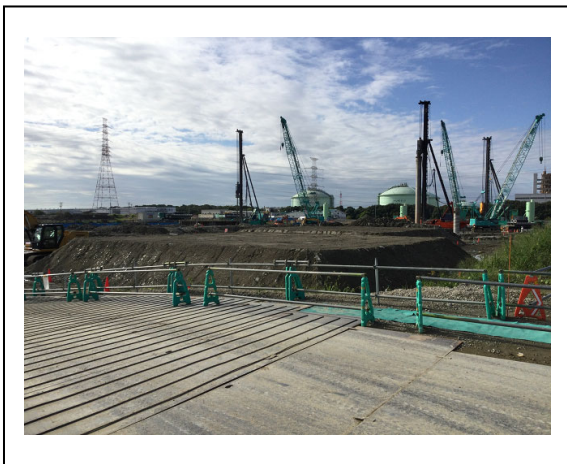
写真 2. 2. 5b ケーシングを用いた杭施工状況
