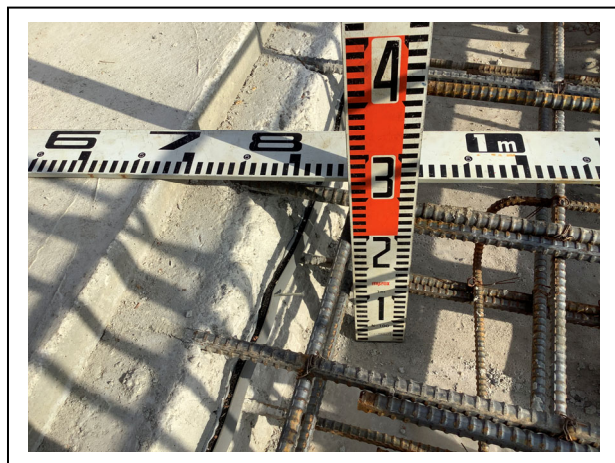
写真 2.2.6b 構造スラブ（管理棟ピット）厚み 250 mm 以上の確認
