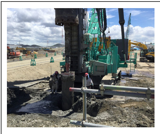
写真 2. 2. 5b ケーシングを用いた杭施工状況
