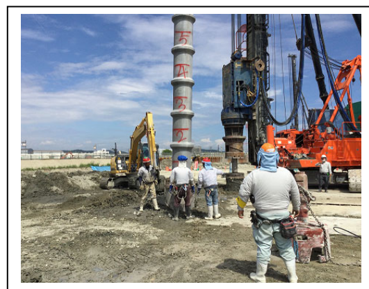
写真 2. 2. 3a 杭打設状況
