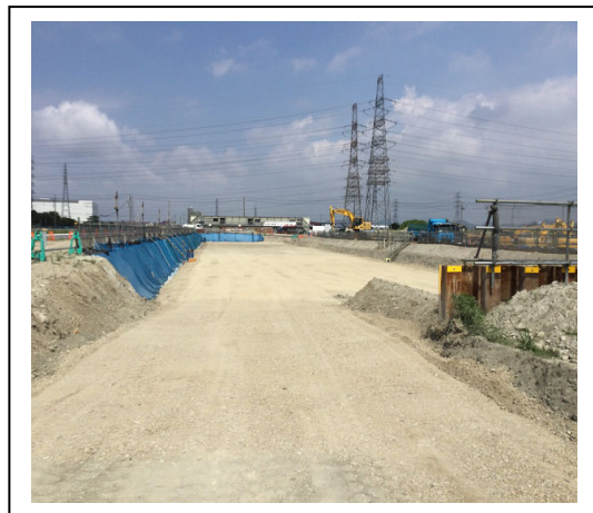
写真 2. 2. 2b 杭打設前基面整生状況
