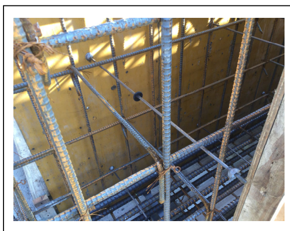
写真 2.2.9b 止水セパレーターの使用状況
