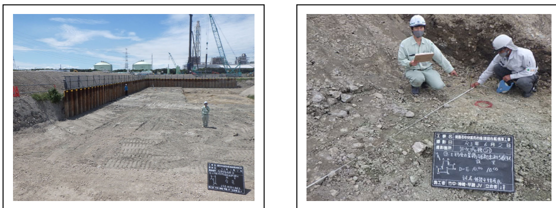
写真 2. 2. 1-4b 盛土移動後の状況 (姫路市営繕課立会い確認状況)
