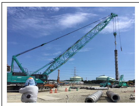
写真 2. 2. 3a 杭打設状況
