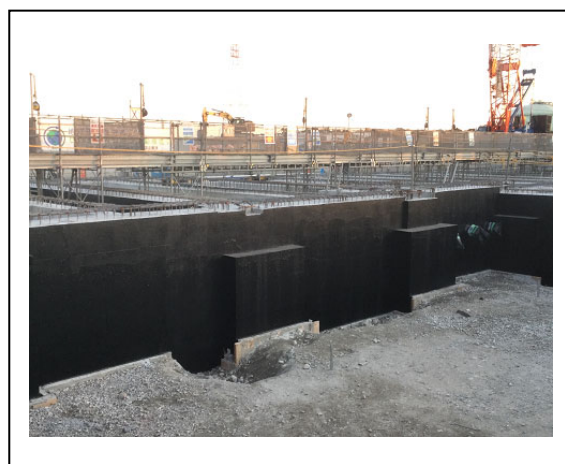
写真 2.2.9c ピット外面の防水施工状況
