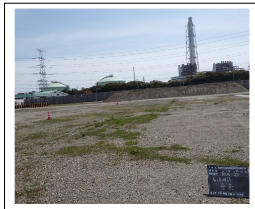
写真 2. 2. 1-1c 着手前状況
