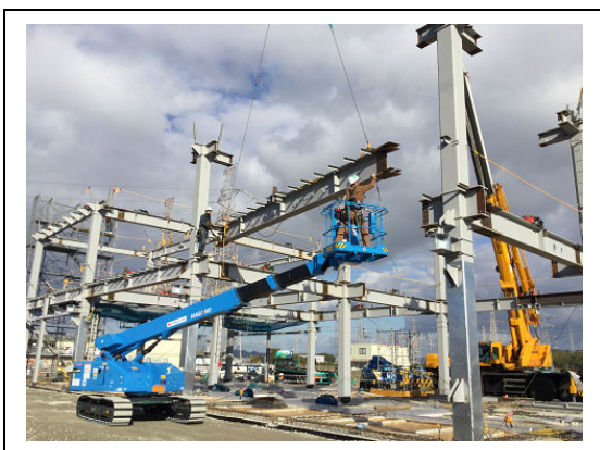
写真 2. 2. 3f 鉄骨建方状況 (管理棟)
