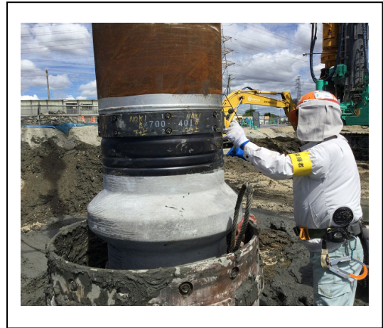
写真 2. 2. 5b ケーシングを用いた杭施工状況
