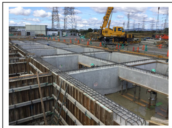
写真 2.2.11c ピット施工状況（管理棟）
