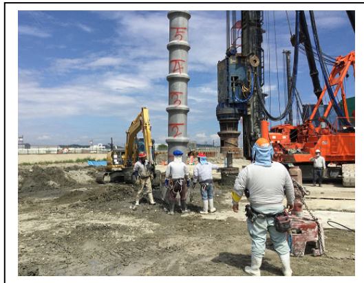
写真 2.2.3a 杭打設状況
