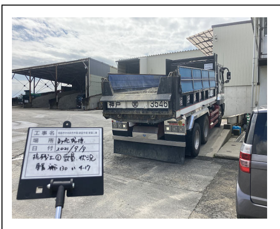
写真 2. 2. 5c 杭残土の仮置き・処理状況
