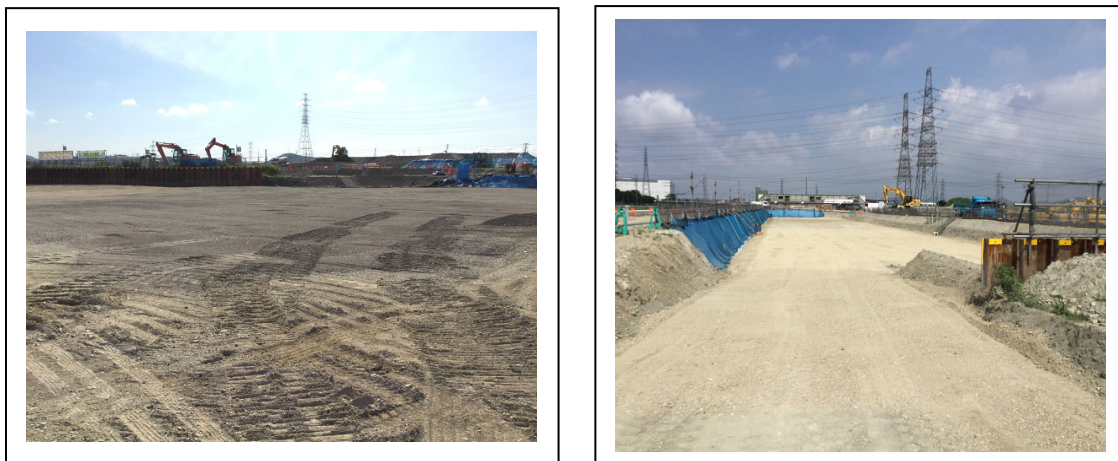
写真 2. 2. 2b 杭打設前基面整生状況
