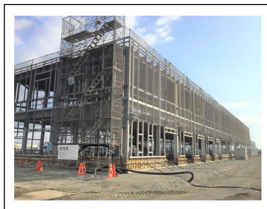
写真 2. 2. 3f 鉄骨建方状況 (管理棟)
