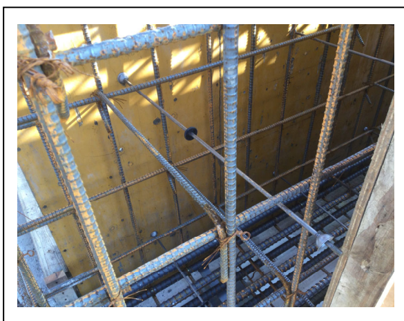
写真 2.2.9b 止水セパレーターの使用状況
