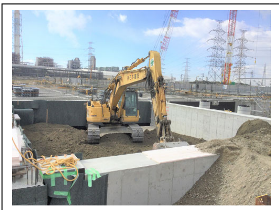
写真 2. 2. 3d 埋戻し状況
