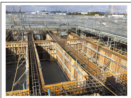
写真 2.2.3c 基礎躯体施工状況（卸売場棟）
