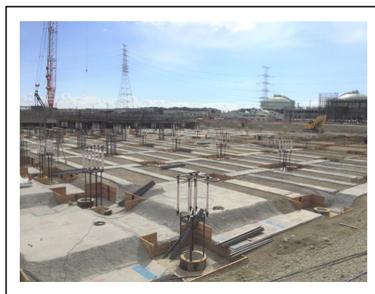
写真 2.2.3c 基礎躯体施工状況（卸売場棟）
