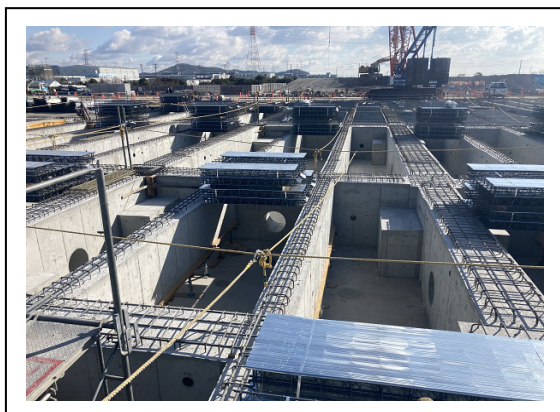
写真 2.2.11b ピット施工状況（卸売場棟）
