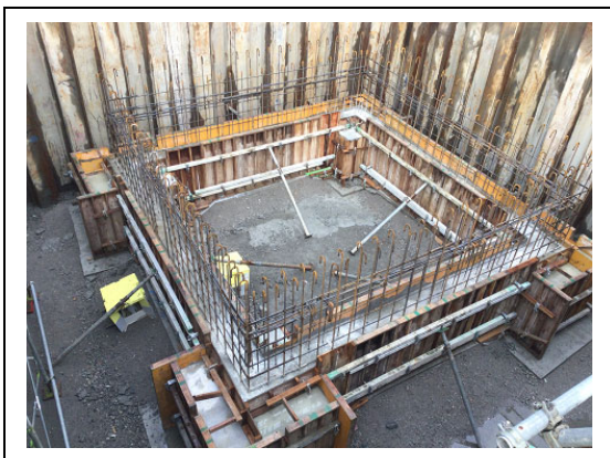
写真 2. 2. 3e 排水槽工事状況
