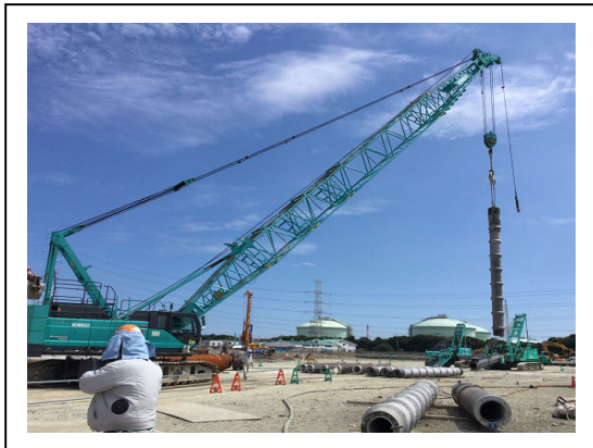
写真 2.2.3a 杭打設状況
