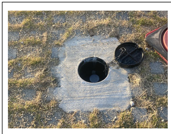
写真 2.2.4b 防護鉄蓋設置状況（蓋内部）
