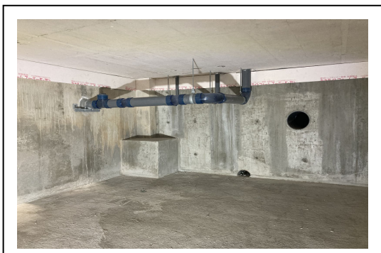
写真 2.2.9b 止水セパレーターの使用状況
