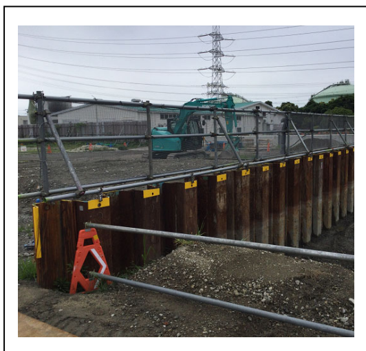
写真 2. 2. 1-3c 混合防止用シートパイル設置状況・通路養生状況
