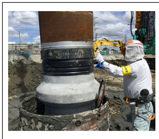
写真 2.2.5b ケーシングを用いた杭施工状況
