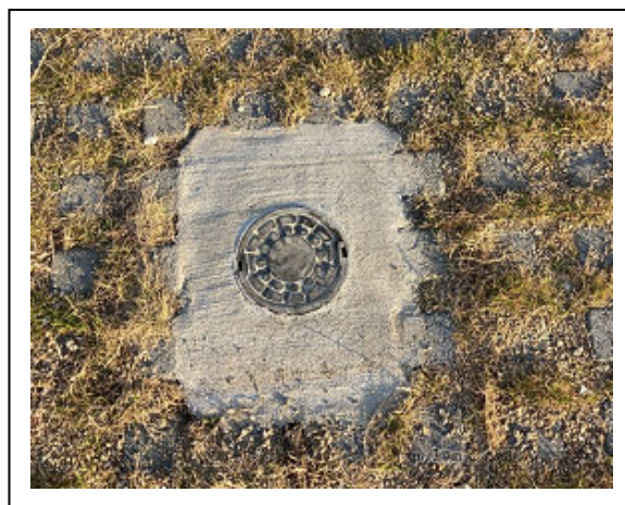
写真 2.2.4c 防護鉄蓋設置状況（表面仕上げ）
