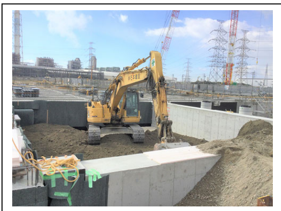
写真 2. 2. 3d 埋戻し状況
