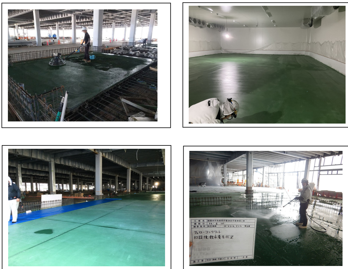
写真 2. 2. 13 塗床仕上げの施工状況
