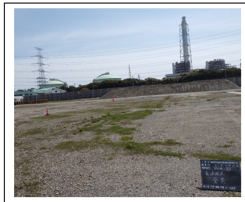
写真 2. 2. 1-1c 着手前状況
