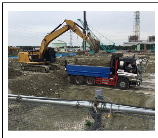
写真 2.2.5b ケーシングを用いた杭施工状況
