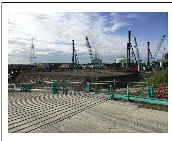
写真 2.2.5b ケーシングを用いた杭施工状況
