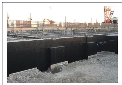
写真 2.2.9c ピット外面の防水施工状況
