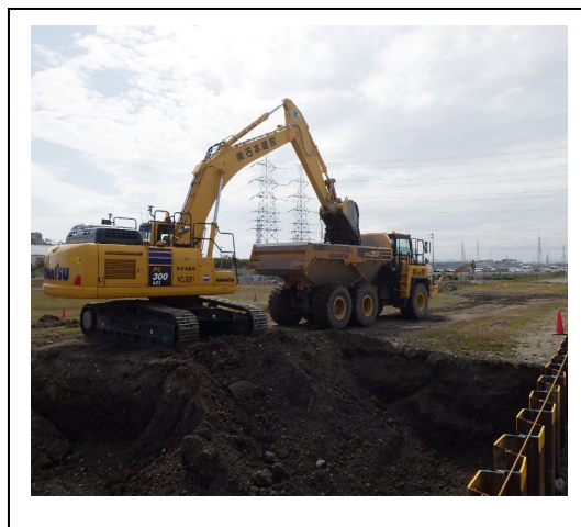
写真 2. 2. 1-3b 盛土鋤取り・積込状況
