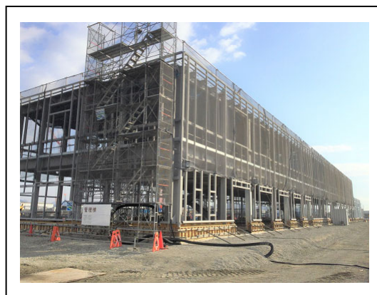
写真 2. 2. 3f 鉄骨建方状況 (管理棟)
