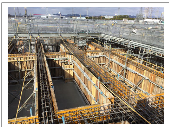
写真 2. 2. 3c 基礎躯体施工状況（卸売場棟）
