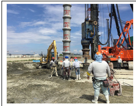
写真 2. 2. 3a 杭打設状況
