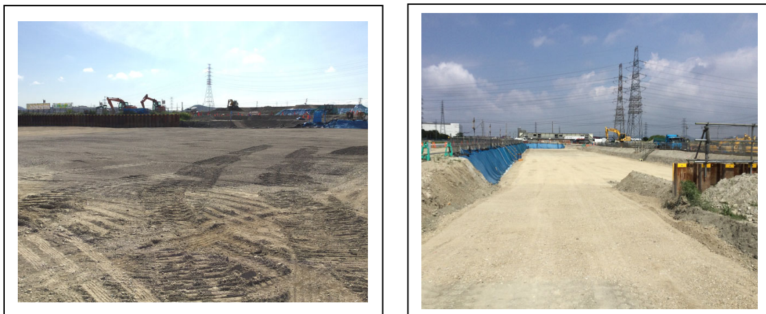
写真 2. 2. 2b 杭打設前基面整生状況
