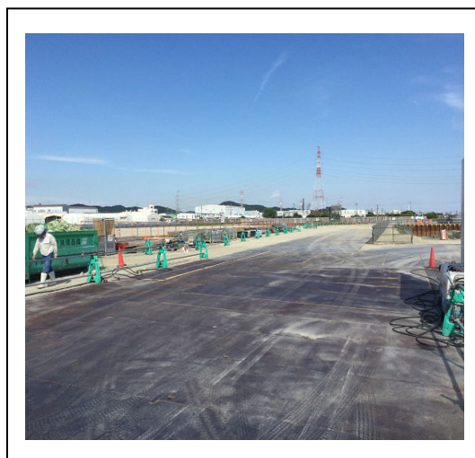
写真 2. 2. 1-3c 混合防止用シートパイル設置状況・通路養生状況
