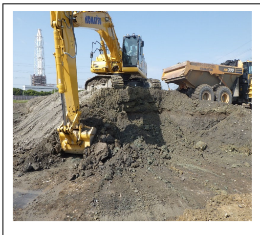
写真 2. 2. 1-3b 盛土鋤取り・積込状況
