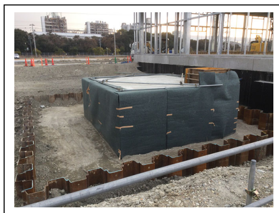
写真 2. 2. 3h 埋戻し状況（排水槽）
