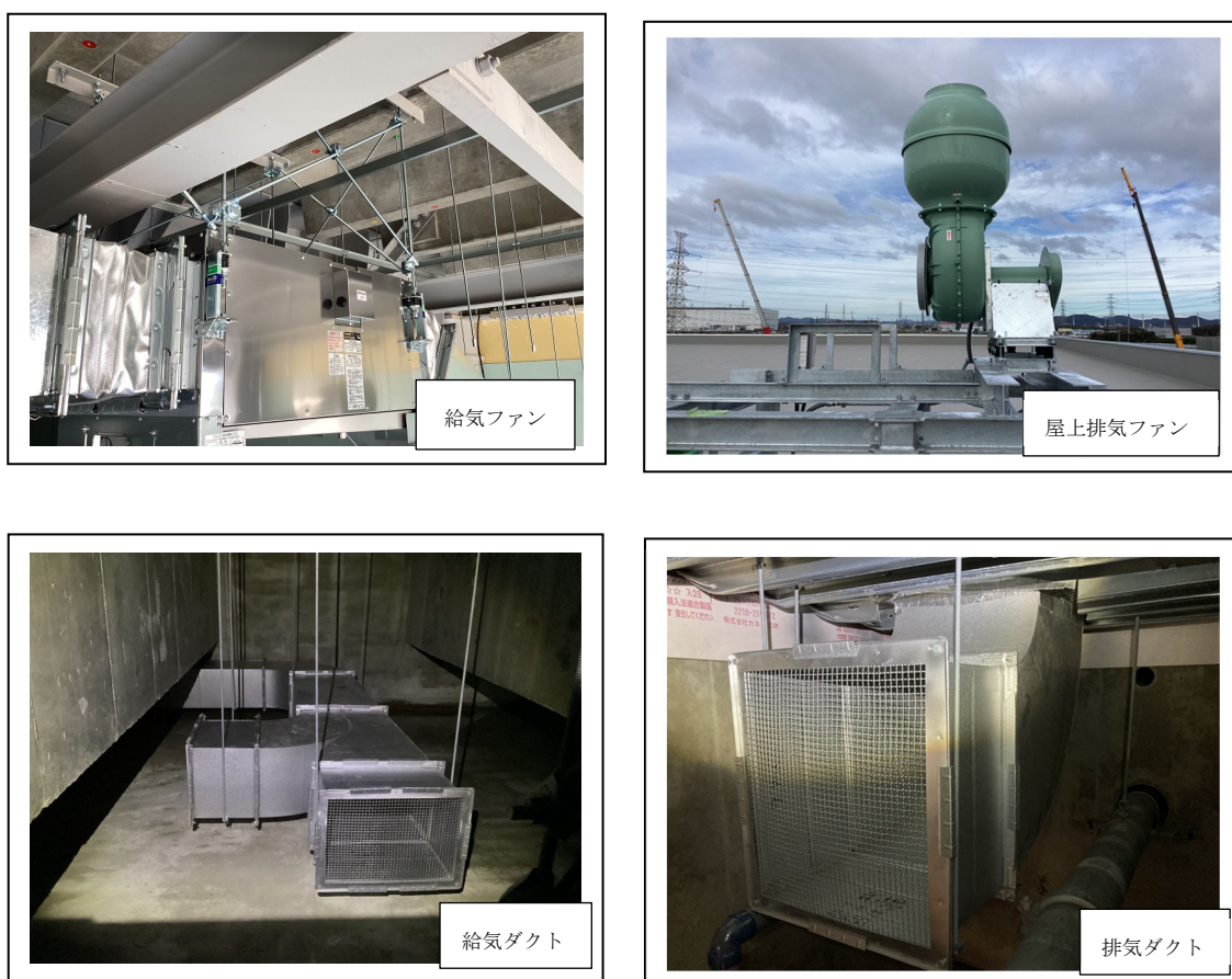
写真 2.2.10 第 1 種換気方式の施工状況
