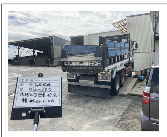
写真 2.2.5c 杭残土の仮置き・処理状況
