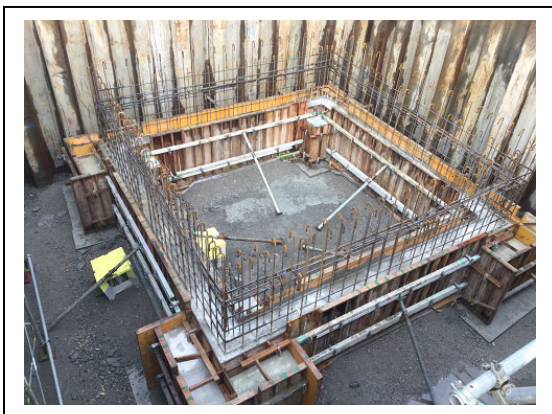
写真 2. 2. 3e 排水槽工事状況
