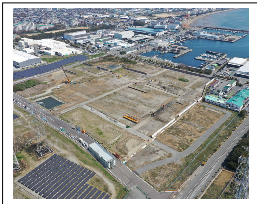
写真 2. 2. 1-1b 着手前全景
