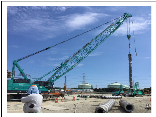
写真 2. 2. 3a 杭打設状況
