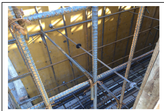
写真 2.2.9b 止水セパレーターの使用状況
