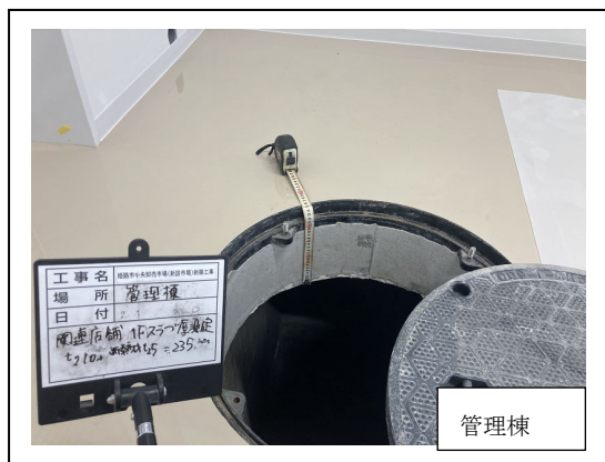
写真 2.2.6c 構造スラブの確認（1F）
