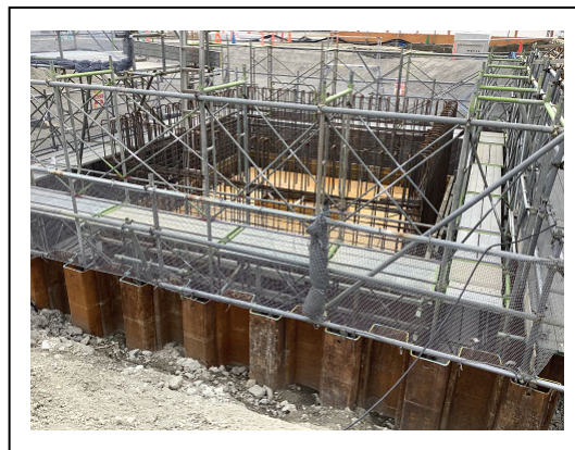
写真 2. 2. 3e 排水槽工事状況
