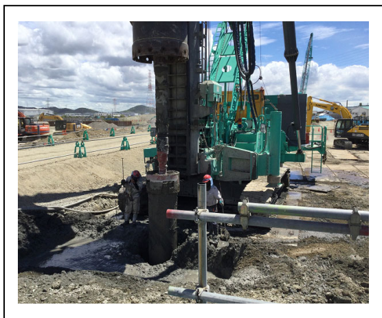
写真 2.2.5b ケーシングを用いた杭施工状況
