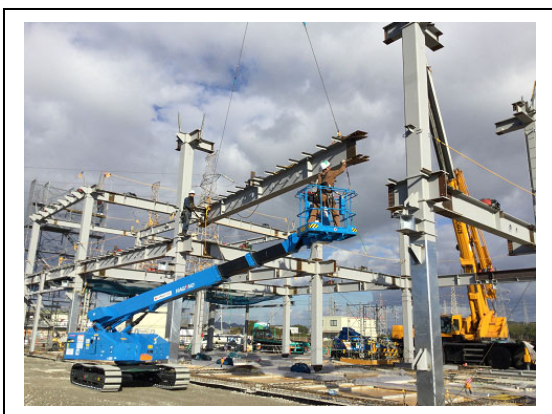
写真 2. 2. 3f 鉄骨建方状況 (管理棟)
