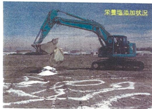
資料-6 対策工事 油含有土壤のバイオ処理
