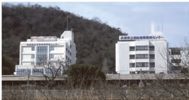
兵庫県立病院（兵庫県立姫路循環器病センター）
