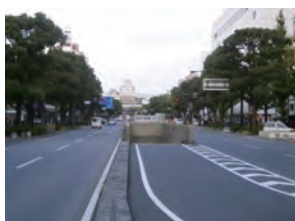
大手前地下駐車場
