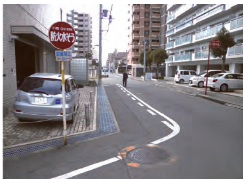
防火水槽（船橋町水槽）
