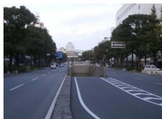
大手前地下駐車場
