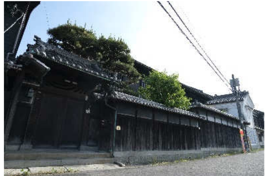
旧水井家住宅
