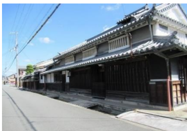
(長谷川家住宅) (都市景観重要建築物等)
