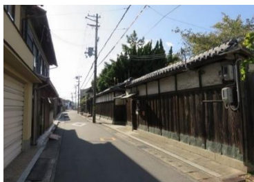
(浜街道(室津下道)沿いの町並み)
