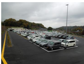
駐車場 (道の駅奥河内くろまるの郷)
