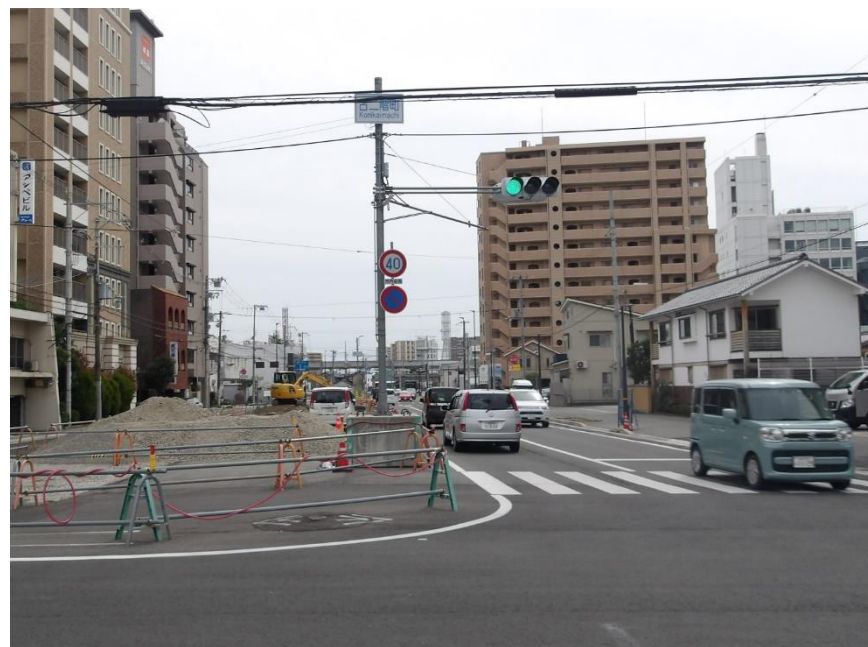
内環状東線 (北から南)整備中
