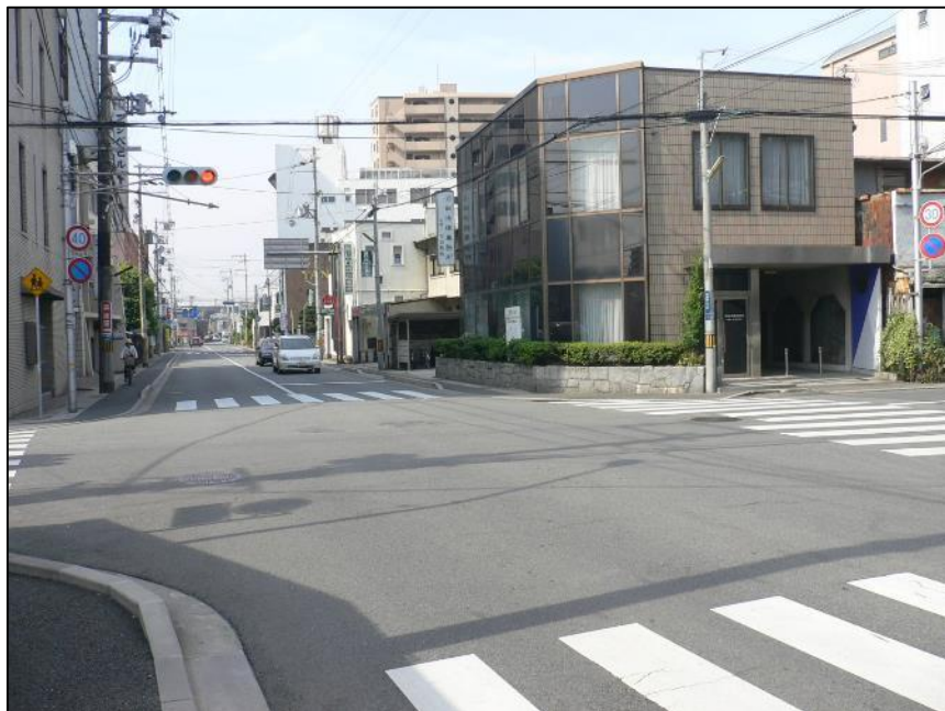
内環状東線 (北から南)整備前
