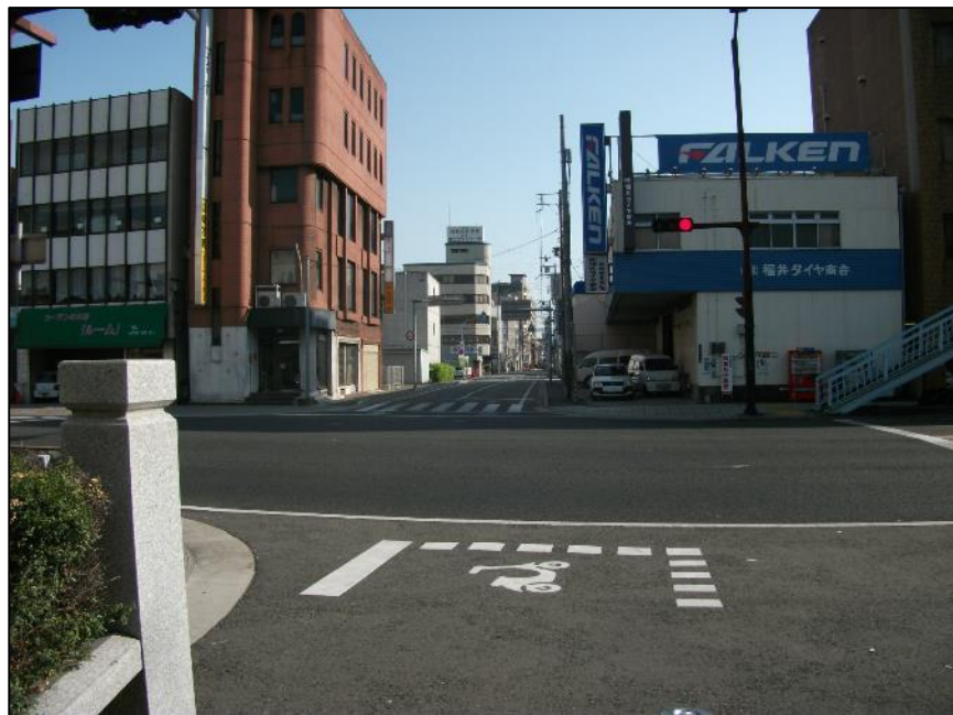
内環状東線(北工区) (北から南)整備前
