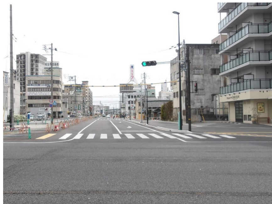
内環状東線(北工区) (北から南)整備中
