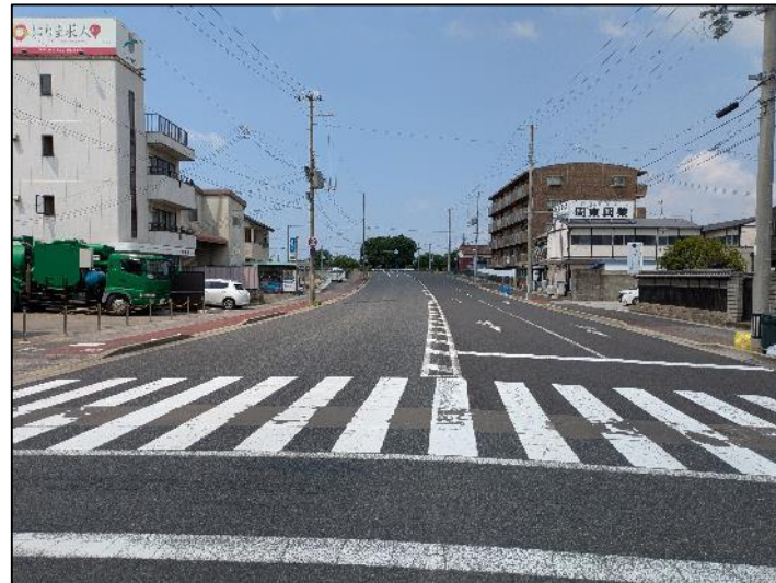
鹿谷田線終点（東から西）事業中
