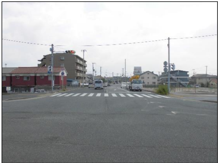
鹿谷田線起点（西から東）事業中
