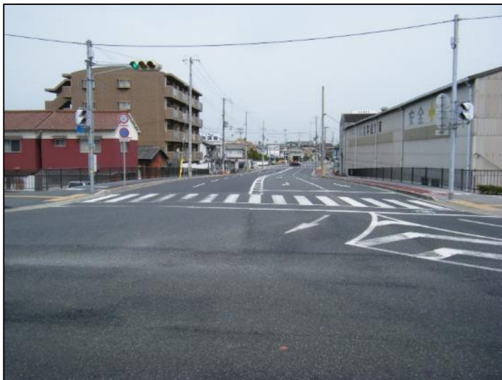
鹿谷田線起点（西から東）事業前
