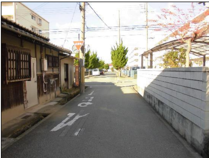
亀山線終点（東から西）事業前
