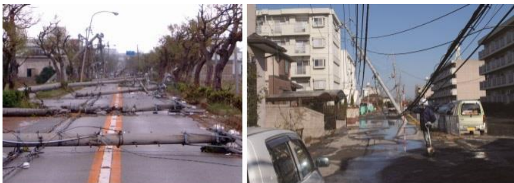
図 2.2 倒壊した電柱による道路閉塞（出典：国土交通省ホームページ）
