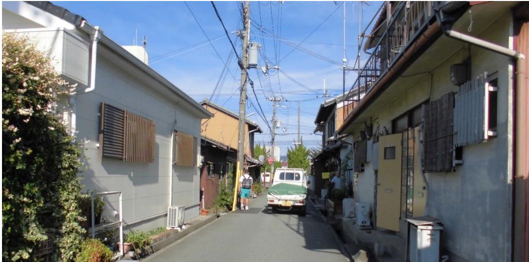
図 2.3 路肩に設置された電柱による通行阻害
