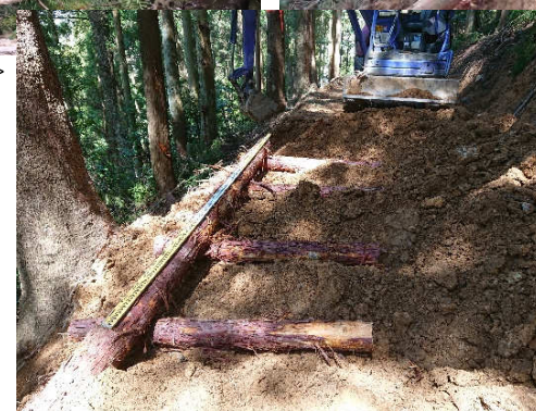
<路面処理工（作業中）>
