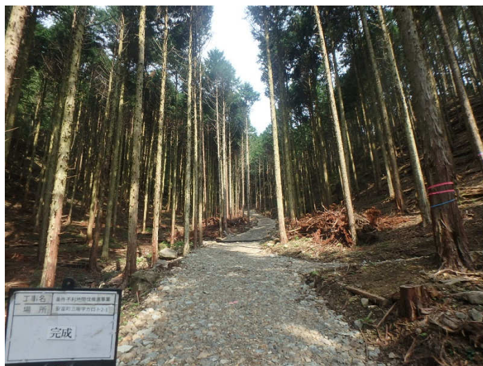
<整備後（安富町三坂地区）>
