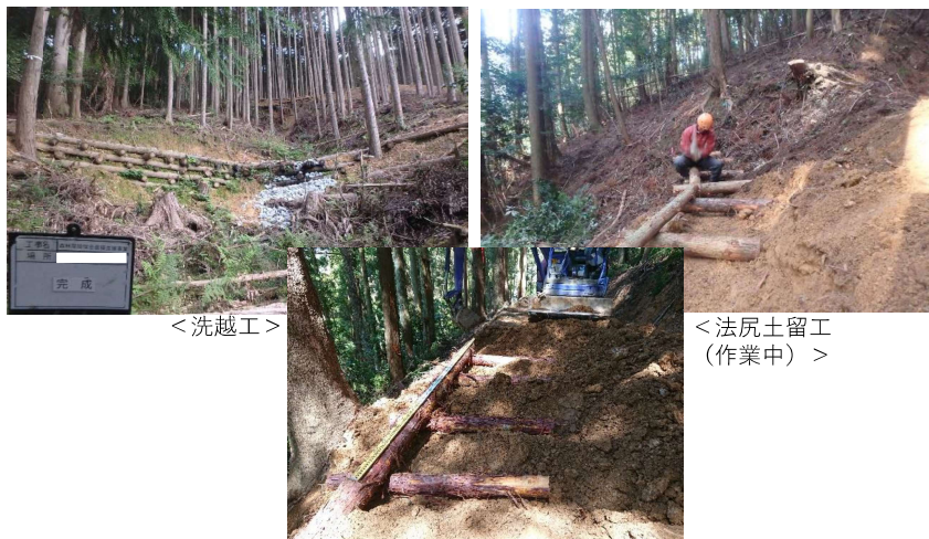
<路面処理工（作業中）>
