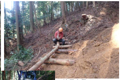
<法尻土留工（作業中）>
