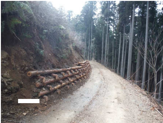
<木製の簡易構造物を設置した「壊れにくい作業道」>
