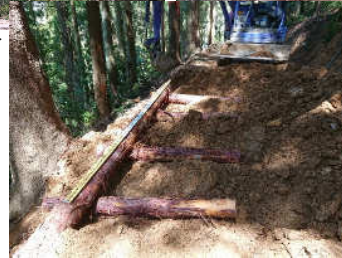
<路面処理工（作業中）>
