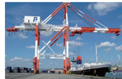
姫路港のガントリークレーン
