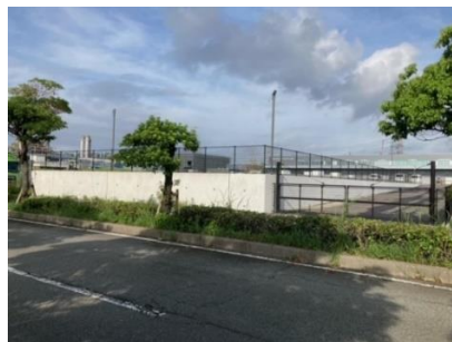
周辺道路より約 1.5～2 m の盛土
