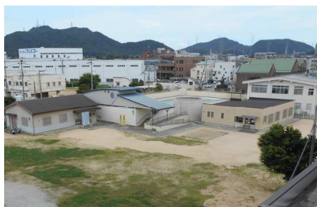
⑭左から放課後児童クラブ、 プール付属棟、第2放課後児童ク ラブ、スポーツ事務所
