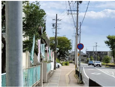
⑳引込柱 西側より敷地に強電引込
