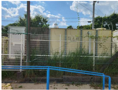
⑲受水槽（平成15年設置）
