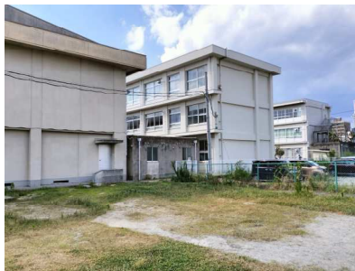
㉓敷地内電柱 ㉒同様
