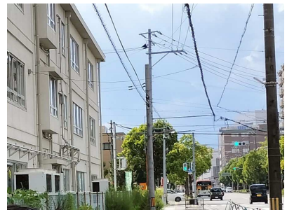
㉔弱電引込 敷地北側よりCATVを引込
