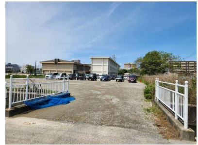
⑥東側道路より敷地を望む
