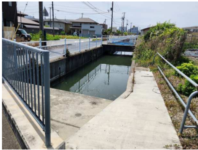
④敷地東側水路
