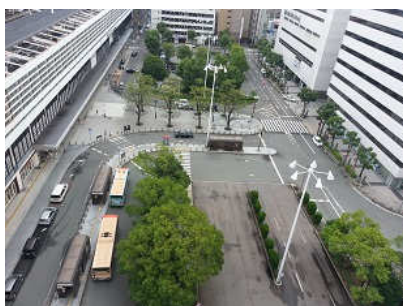
南駅前広場現況（西方より）
