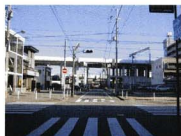
内々環状西線の現状
