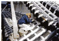
姫路城壁漆喰の修理
