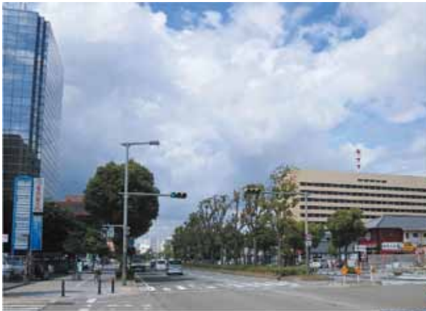
区画整理により整備された駅南大路
